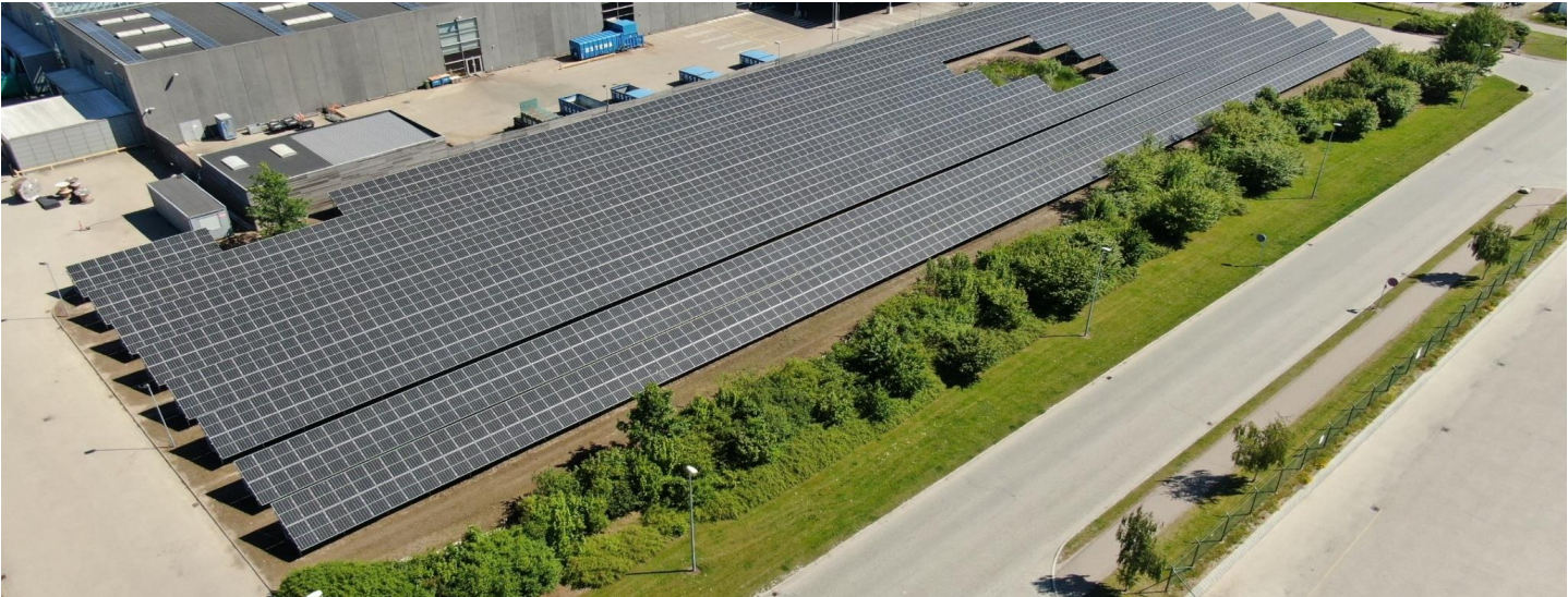
Solcellepaneler hos FK Distribution i Taastrup
